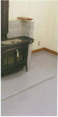
←【パーモントキャストिंगス】アンコール / 炉台：コンクリートブロック / 壁：コンクリートブロック / 屋内煙突：断熱二重煙突
