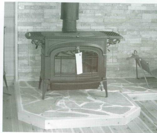
ストープ部を大きく、用具置き場を小さめにつくった変形の2面炉台。床は大石タイル、壁は乱張りタイル。どちらも手割り風のランダムな石なので、表情豊かな仕上がり。木の壁の雰囲気にもびつたり似合っている
