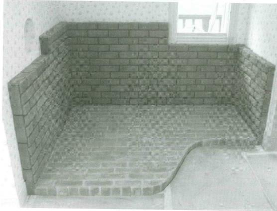
部屋のくぼみをストープコーナーにしたコの字型炉台は、床も壁も赤レンガを使用。壁と床のレンガの種類と目地の色、仕上げ方を変えている。どちらも小口積んだときの側面は薄いタイルレンガを貼って仕上げています
