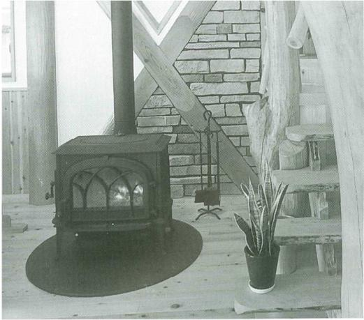
円形の鉄板のシンプルな炉台。壁から離れていれば、これだけでも十分。四方に熱が行くので暖房効率も高い
