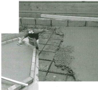
5. 鉄筋を敷き詰めモルタルを流し込む
