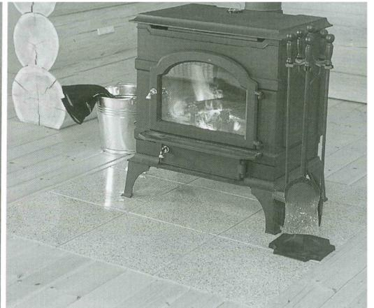
床にタイルを埋め込んで段差をなくしたモダンな炉台。薪ストーブはタッチウエストのエンライト
