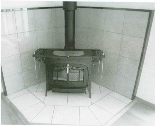
ツヤのある大きめの正方形タイルを使った例。五角形の床は、正方形を並べずに、カットしたタイルを組み合わせているのがポイント。白いタイルと黒いストーブのコントラストが、シンプルでモダンな仕上がり
