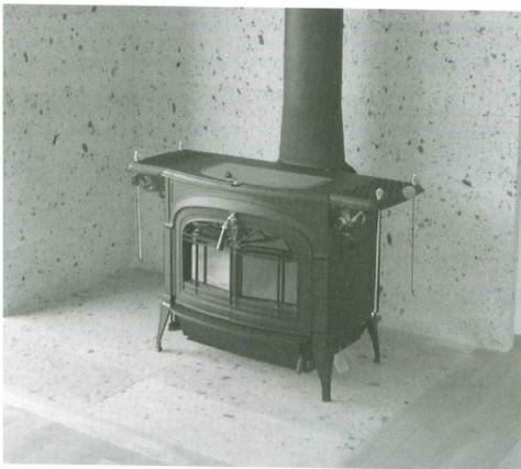
壁、床ともに大谷石を使用。壁の高さが天井近くまであっても、シンプルな石なのですっきり仕上がった。床は上面をフローリングと同じ高さにしたバリアフリー仕様。使いやすく、部屋との一体感も生まれ
