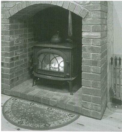
ヨツールの薪ストーブを、欧米風にレンガで囲い込んだシックな炉台。煙突も壁の中に入れている
