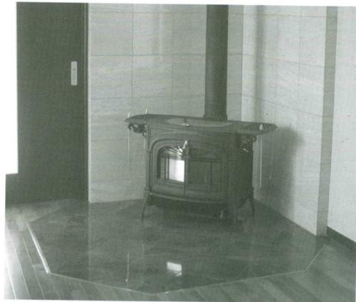
奥行きをたっぷりとしたタイル製の炉台は、壁は白、床は黒を組み合わせ。壁は天井いっぱいの高さに、床はちよつと変わった大きな七角形。バリアフリーにしてすっきり、使いやすく掃除もしやすいタイプ
