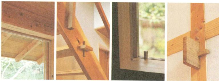
岩崎邸のディテール。左より、追っ掛け大栓継ぎとした桁材。/ 金物を使わず組み上げた階段。/ 窓の錠にはクレセントを使わず、小さな木栓を。/ 鼻先を出した柱梁の取り合い。
