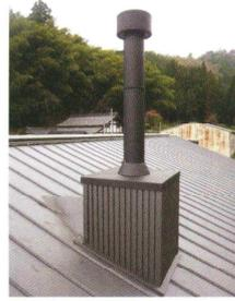
↓【レジャン】マーン&ネンター LG / 炉台：天然御影石 / 壁：天然御影石 / 煙突：ストーブ周りのみシングル煙突、他は断熱二重煙突、屋根出し、囲いフラッシング断熱煙突、丸トップ。煙突を屋内に通すことで暖を得ることもできる
